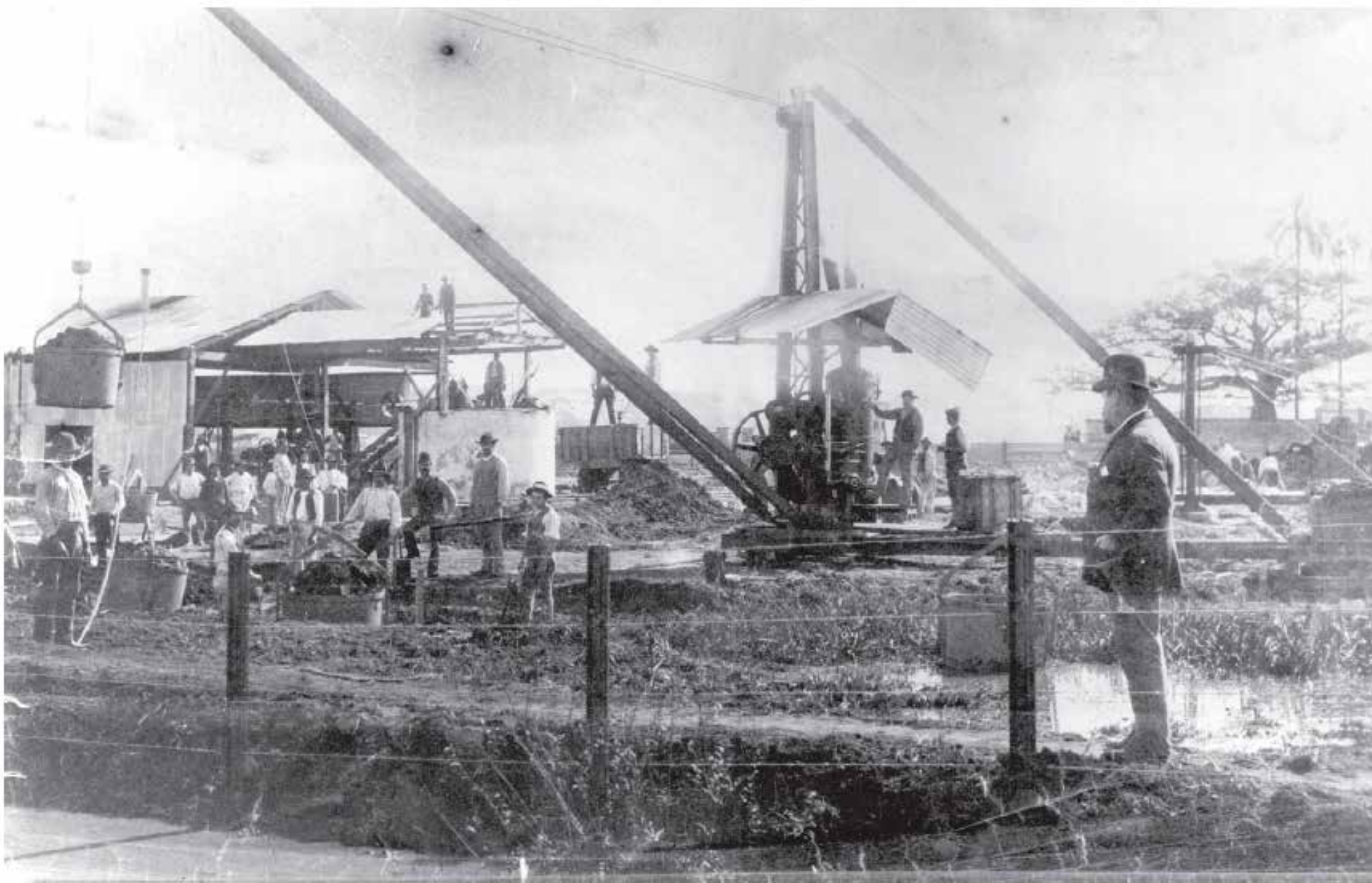
Figura 65: Construção do tanque de água do balão de gás n. 1, na rua da Figueira, Brás. 1895. Atrás, ao lado direito, vê-se a figueira-brava. Fonte: Acervo Fundação Energia e Saneamento.
