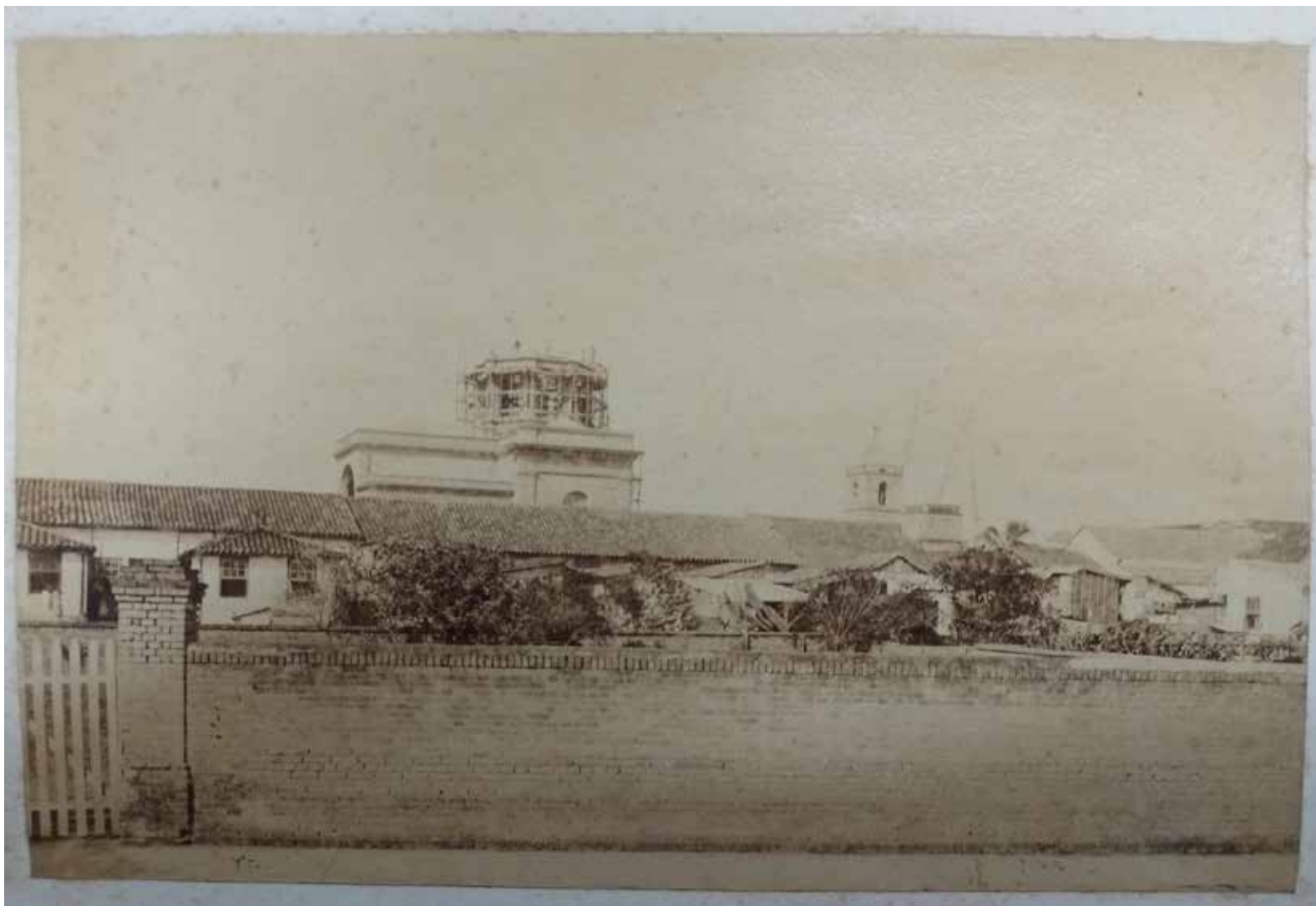
Figura 81: Fotografia lateral da construção da cúpula, recebendo o devido reforço estrutural para escorar-se na estrutura dos pilares da igreja edificada. (1899) Fonte: Arquivo da Cúria
